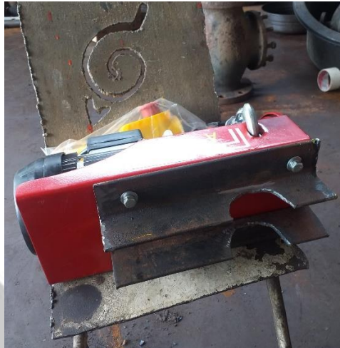
Gambar 3. 17 Pembuatan dudukan hoist
