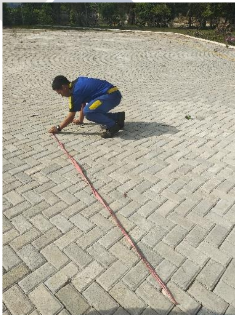
Gambar 4. 2. Mengukur Radius Belok Proyek Sebelumnya
