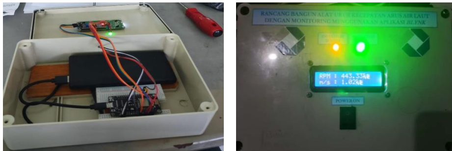
Gambar 3.5 Perakitan pada Kotak Panel
