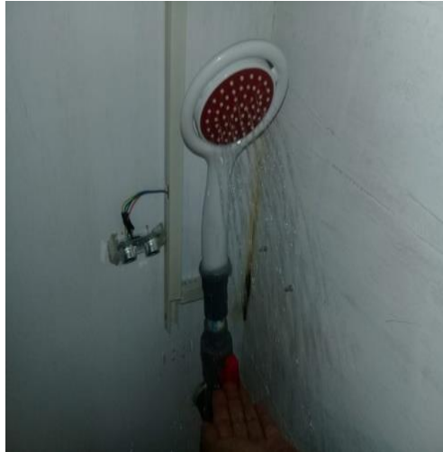
Gambar 4.17 Shower setelah diuji
