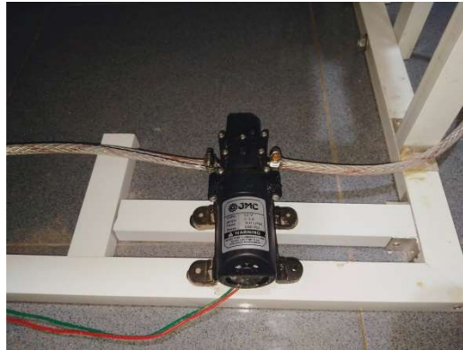
Gambar 3.15 Pemasangan Pompa Air
