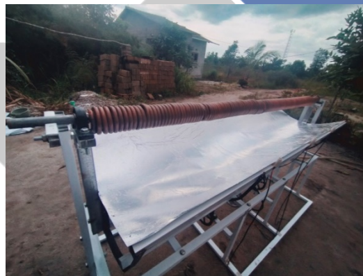
Gambar 3.10 Pemasangan reflektor parabolik
