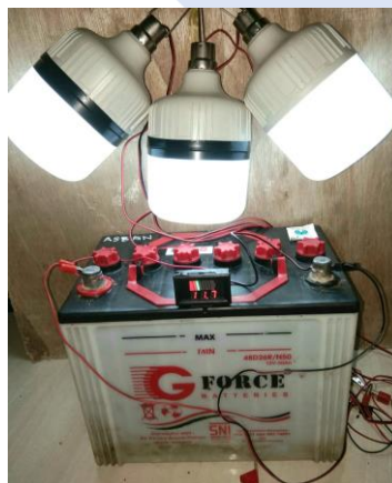
Gambar 4. 24 Pengujian Pengosongan Baterai
