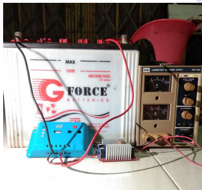
Gambar 4. 11 Pengujian SCC dengan Tegangan Input 5 Volt
