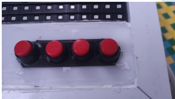
Gambar 4. 5 Pemasangan Push Button
