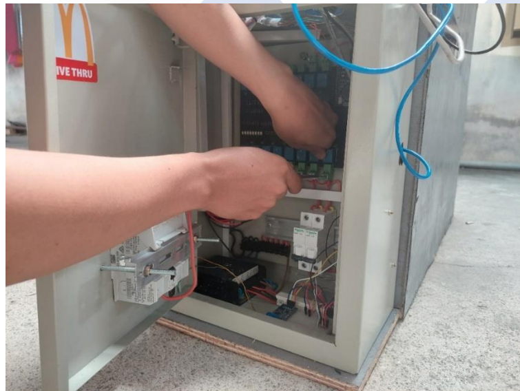
Gambar 4. 3 Proses Pemasangan Komponen-Komponen
