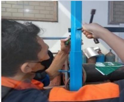
Gambar 4. 57 Proses Pengencangan Penyangga Pipa Pengarah
