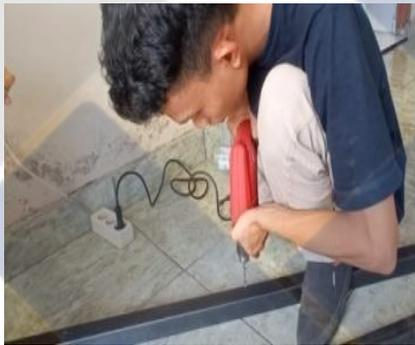
Gambar 4. 47 Proses Pengeboran untuk Pengarah
