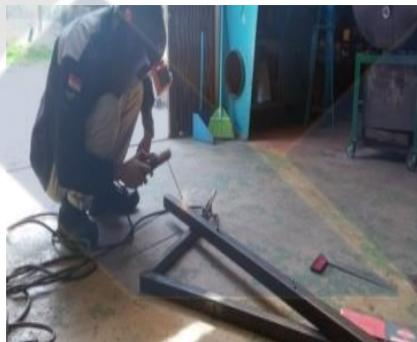
Gambar 4. 42 Pengelasan Pengunci Tiang
