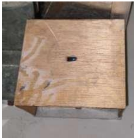
Gambar 3. 16 Pemasangan Dudukan Peletakan Gelas
