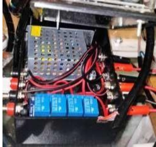
Gambar 3. 26 Pemasangan Komponen Relay 4 Channel
