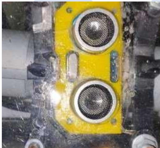
Gambar 3. 22 Pemasangan Komponen Ultrasonik Deteksi kapasitas wadah
