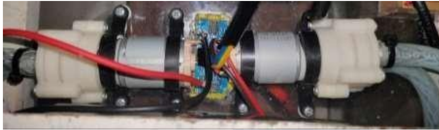
Gambar 3. 23 Pemasangan Komponen Pompa DC 1 dan Pompa DC 2
