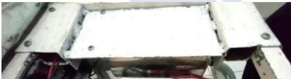
Gambar 3. 13 Pemasangan Dudukan Tabung Pemanas
