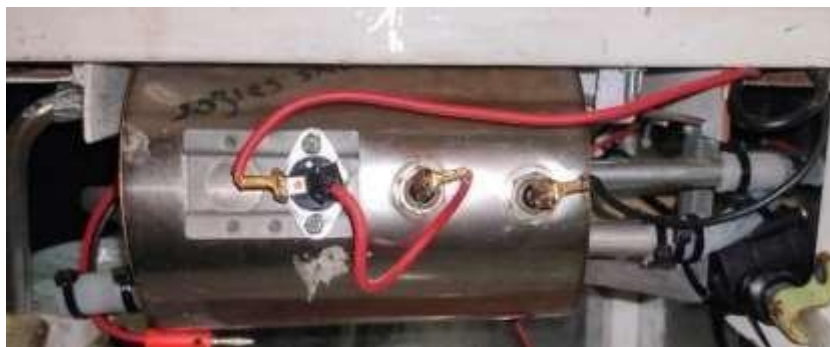
Gambar 3. 24 Pemasangan Komponen Heater
