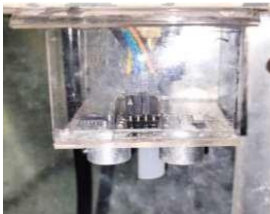
Gambar 3. 15 Pemasangan Dudukan Sensor Ultrasonik
