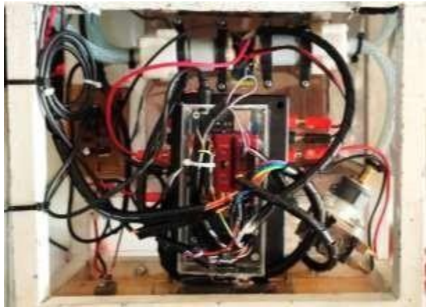
Gambar 3. 12 Pemasangan Dudukan Hardware Kontrol
