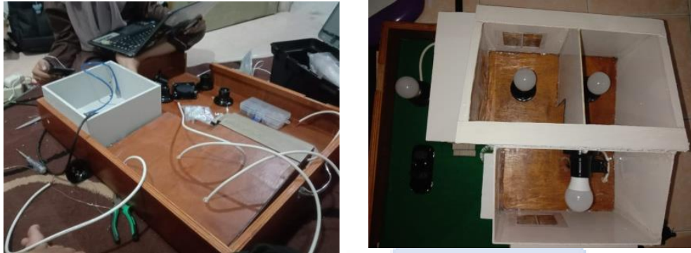
Gambar 4. 14 Proses Pemasangan Perangkat Elektronik ke dalam Rumah
