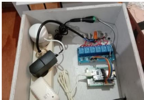
Gambar 4. 13 Peletakan Mikrokontroller ke dalam Box
