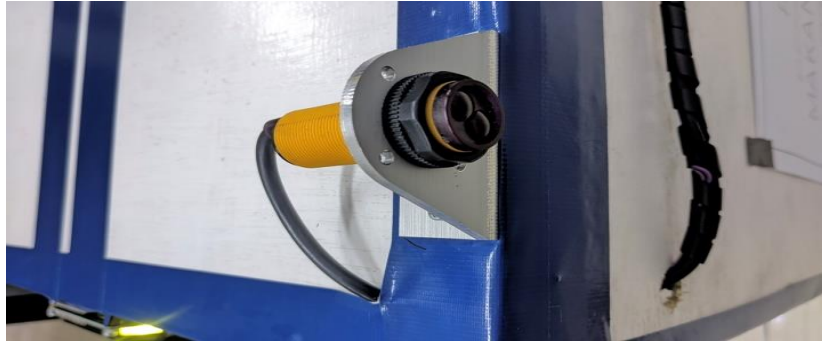
Gambar 4. 8 Pemasangan Sensor Proximity
