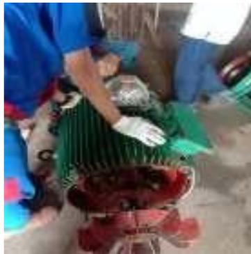
**Gambar 4.32** Proses pembongkaran motor CEP 1B
