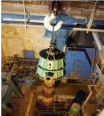
**Gambar 4.33** Proses pengangkatan dan pemindahan pompa CEP 1b
