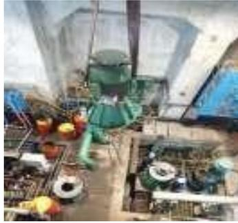
**Gambar 4.31** Proses pengangkatan motor CEP 1 B
