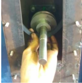
Gambar 4. 4 Pemasangan Pulley Output
