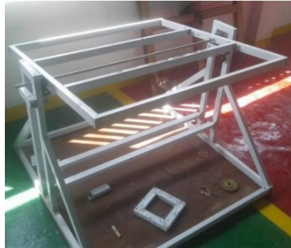
Gambar 4.4 Pemasangan Solar Tracker
