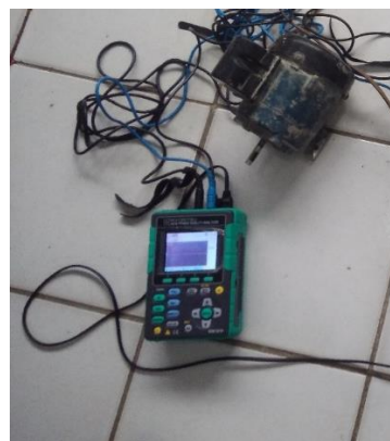
Gambar 4. 24 Pengukuran Menggunakan Power Quality Analyzer
