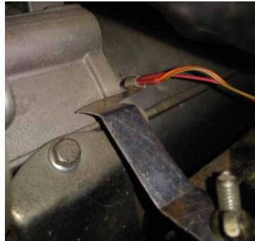
Gambar 4.23 Pemasangan Sensor Suhu
