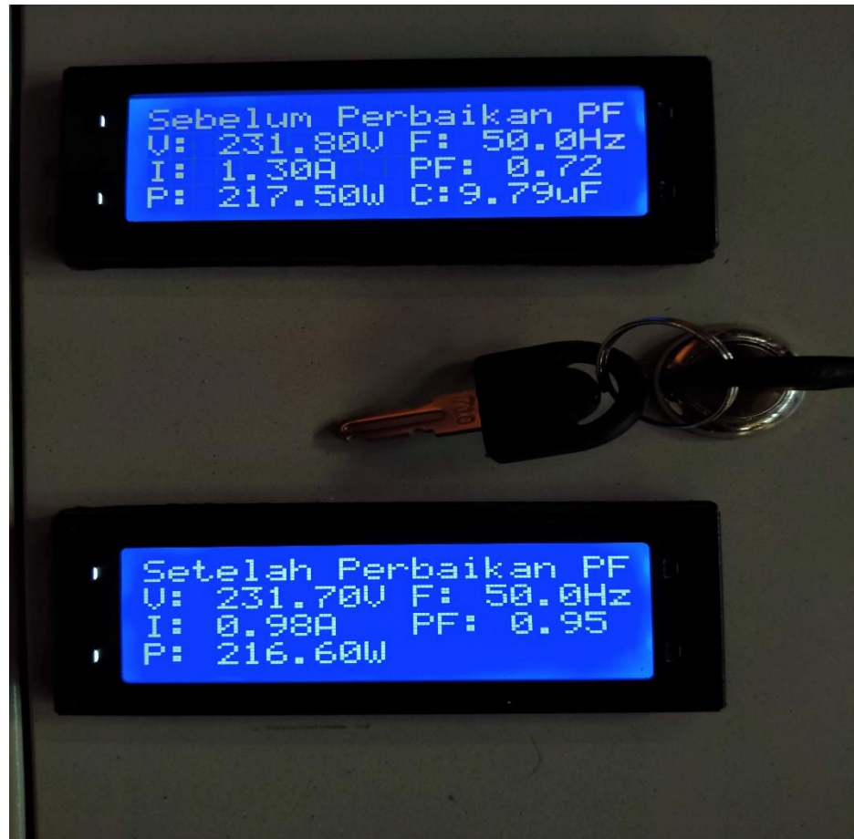
Gambar 4. 12 Hasil Sebelum dan Sesudah Perbaikan PF Pompa Air + Kipas Angin
