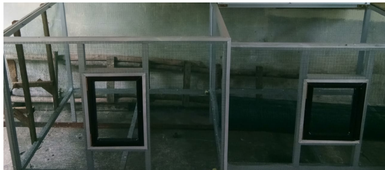
Gambar 4.11 Kerangka Utama Kandang Ayam Tanpa Dilapisi dengan Triplek
