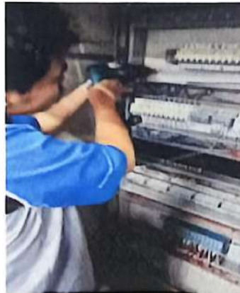
Gambar 2. 2 Pengeboran dan Pemasangan Mccb
