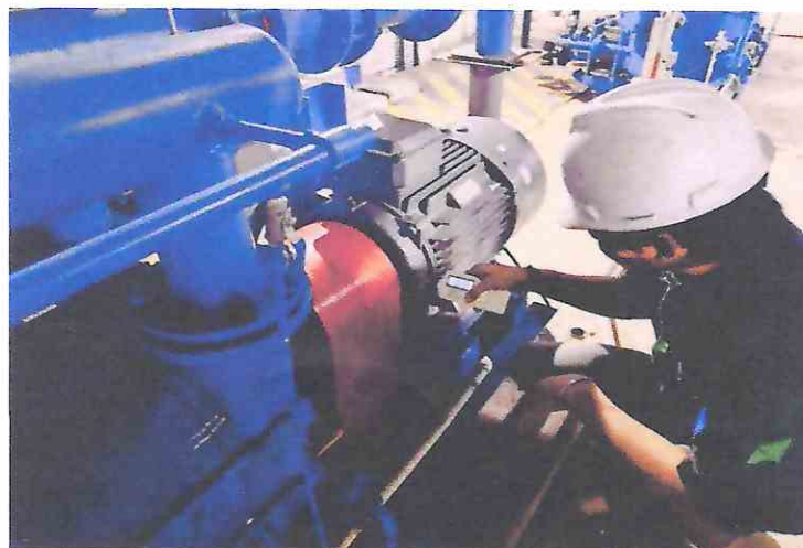
Gambar 2.11 Kegiatan pengambilan vibrasi dan suhu
