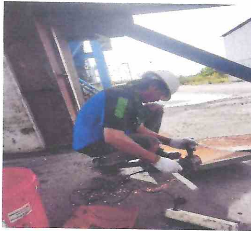
Gambar 2.4 Memotong plat besi untuk pembuatan bak abu boiler
