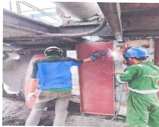
Gambar 2.5 Pengelasan pembuatan bak abu pada boiler
