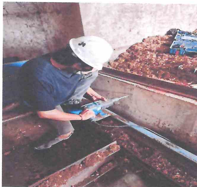
Gambar 2.9 Kegiatan pemasangan baut
