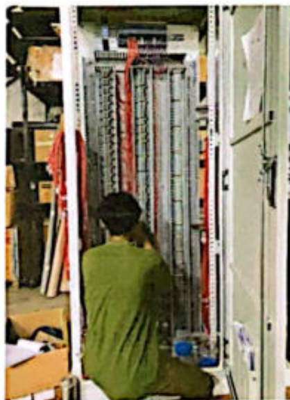
Gambar 2. 10 Wiring module ke terminal
