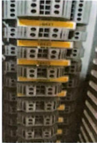
Gambar 2. 7 Hasil Pemasangan Tape ke dalam DLM
