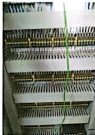
Gambar 2. 6 Hasil penempelan tape untuk Marking komponen
