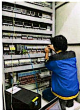
Gambar 2. 3 Continuity dan cek I/O list module PLC
