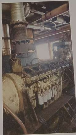
Gambar 2.1 Perbaikan Mesin Diesel Kapal
