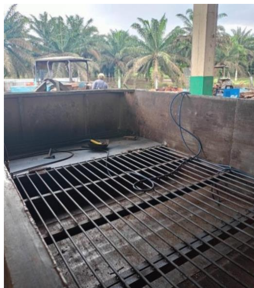
Gambar 2. 7 Renovasi Bak Mobil Fuso
