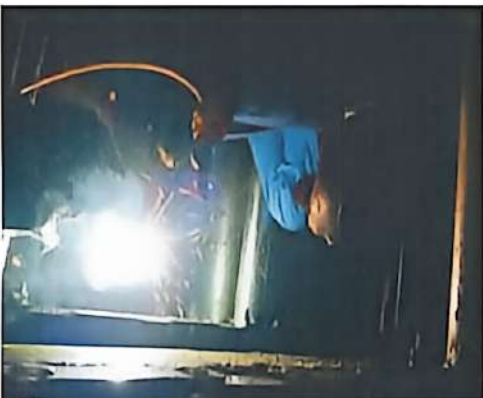
Gambar 2.0 Pengelasan Stasiun Sterilezer
