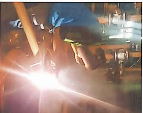
Gambar 1.9 Pengelasan Pipa Stasiun Klarifikasi
