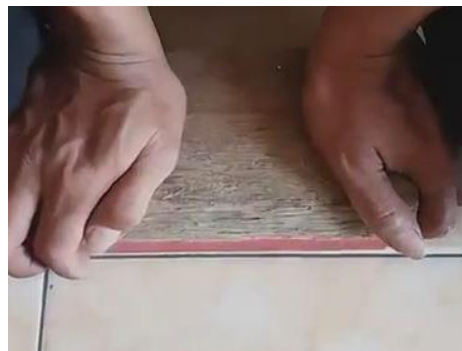
Gambar 1.4. Proses penekanan dengan kayu balok
