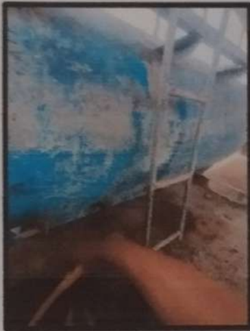
Gambar 2.5 Membersihkan sisa cat lama yang menempel di tangka air
