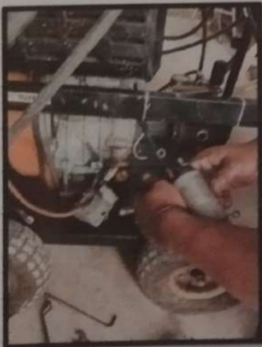
Gambar 2.0 mengganti dinamo yang rusak pada alat steam
