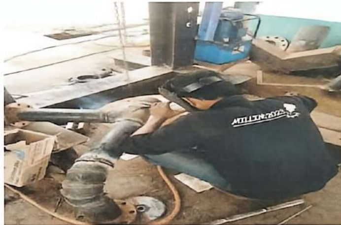
Gambar 2.9 Penyambungan pipa dengan cara pengelasan
