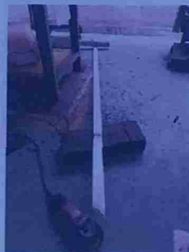
Gambar 2. 3 Pembuatan Tray Kabel
