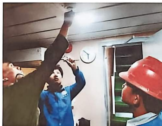
Gambar 2.13 Pengecekan smoke detektor .
