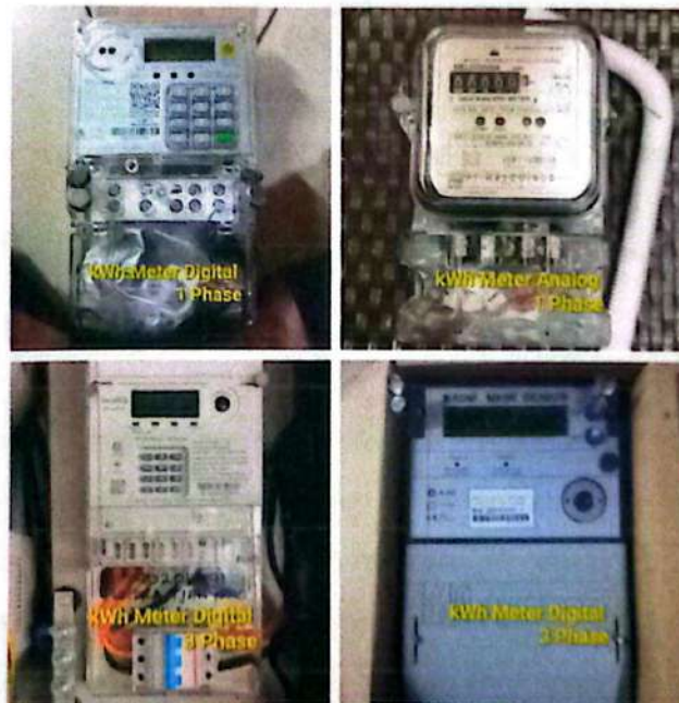
Gambar 2.2 kWh Meter 1 Phase dan 3 Phase
