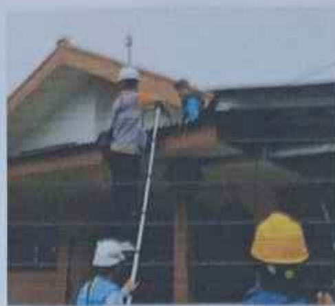
Gambar.16 Pergantian kabel dan kwh
