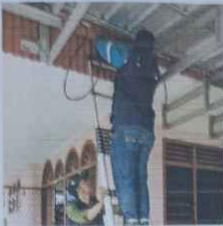
Gambar.16 Pergantian kabel dan kwh
