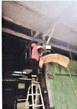
Gambar 2. 7 Pemasangan Lampu Sorot
