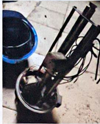
Gambar 2. 8 Membantu Membersikan Mobrey di Stasiun Boiler
