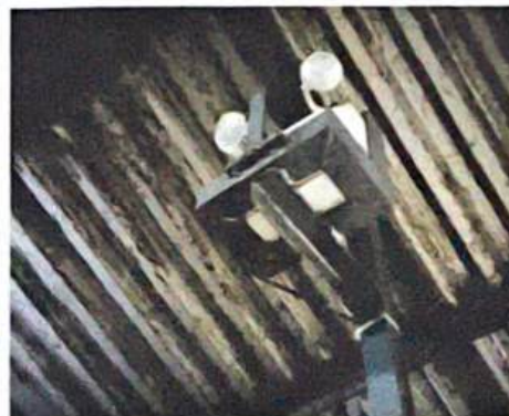
Gambar 2. 17 Membantu Memasang lampu emergency
