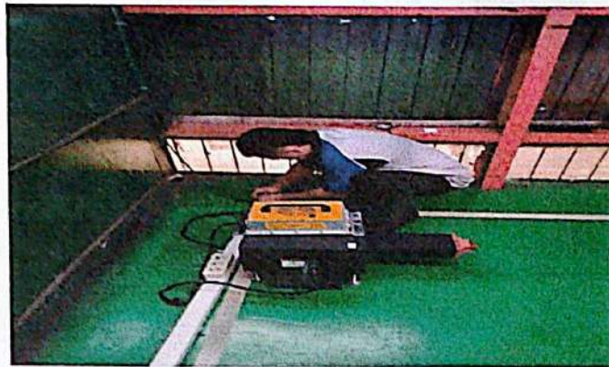
Gambar 2. 1 pembuatan instalasi charger AMR Forklift.
