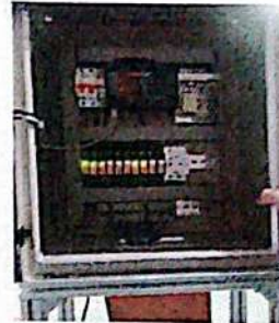
Gambar 2. 2 Pemasangan langsung komponen panel.
