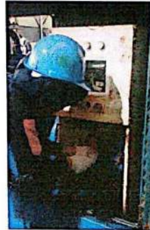
Gambar 2. 12 Pembongkaran panel listrik generator 150 kVA
