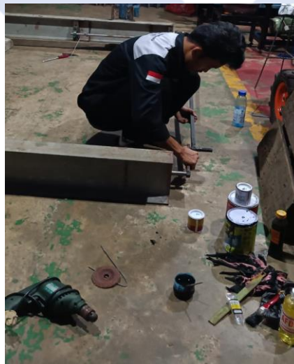
Gambar 4.11 Proses pemasangan tuas penggerak.
