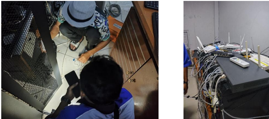
Gambar 2.3.3 Aktivitas Instalasi Jaringan
