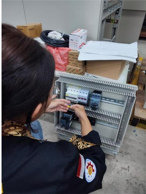
Gambar 2. 27 *Tapping* Komponen PANEL DOL FOR PUMP
