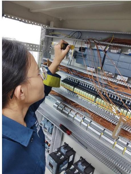
Gambar 2. 9 *Wiring* modul AI/AO PANEL COS CMP VSD *Cell 3*
