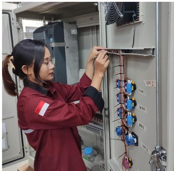
Gambar 2. 4 *Wiring PB, EM, dan SS* PANEL COS CMP VSD Cell 1
