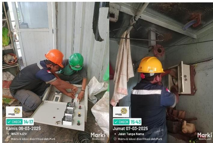
Gambar 2. 4 Instalasi Panel Listrik dan Sistem 3 Fasa
