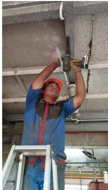
Gambar 2. 3 Instalasi Lampu Sorot
