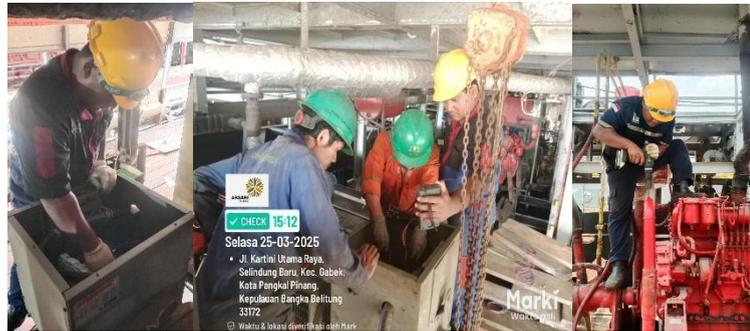
Gambar 2. 5 Genset: Instalasi, Cek, dan *Test Running*
