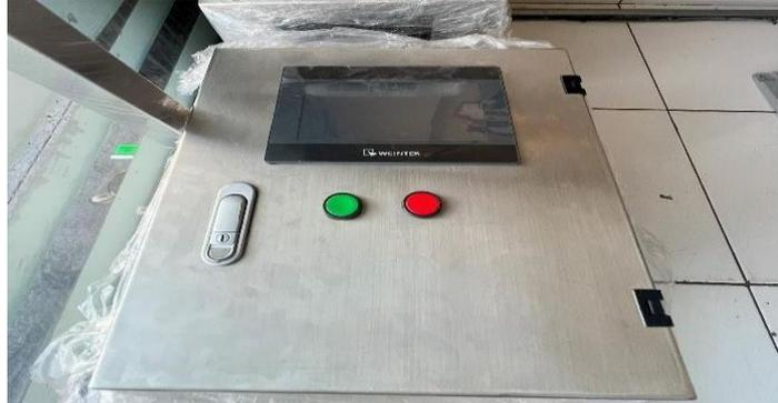
**Gambar 1. 4 Panel PLC dengan *HMI application***
