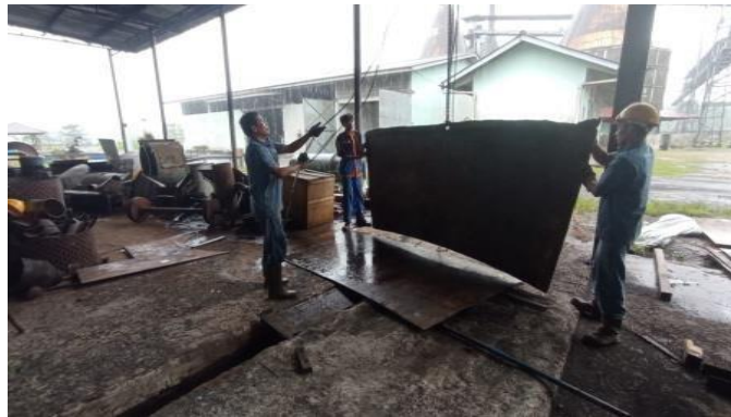
Gambar 2.5 Fabrikasi pintu sterilizer ex
