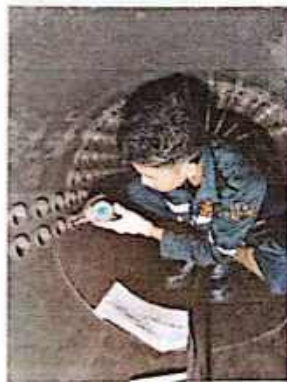
Melakukan pengukuran terhadap pipa water drum boiler.
