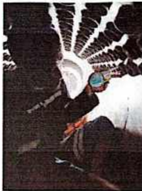
Melakukan pengukuran terhadap pipa water drum boiler.
