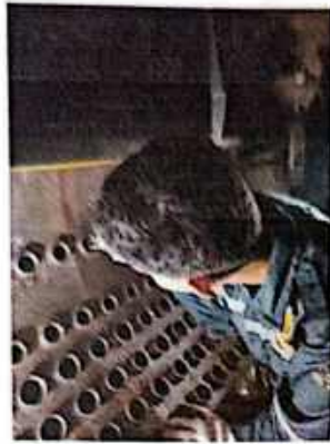
Melakukan pengukuran terhadap pipa steam drum boiler.
