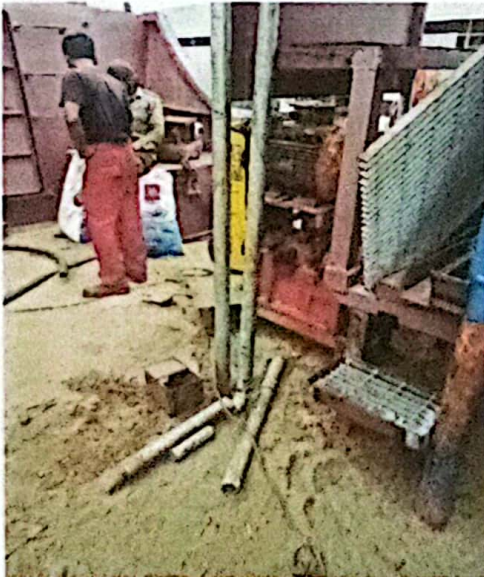
Gambar1.25 Pergantian pipa kabel 2inch blower untuk pompa indeker KM.geotin 1
