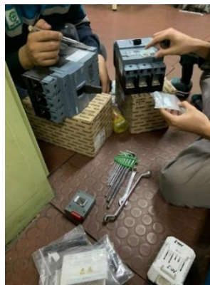
Gambar 2. 19 Pengantian MCCB PT.PELNI
