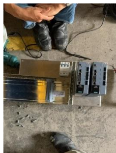
Gambar 2. 8 Pemasangan Komponen PT.Machroprima Panganutama
