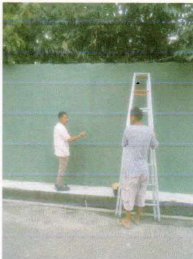
Gambar 1.7 Perbaikan Kabel CCTV yang putus
