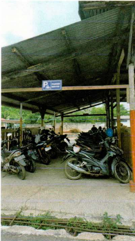
Gambar 1.8 Pemasangan Plang dan Kayu
