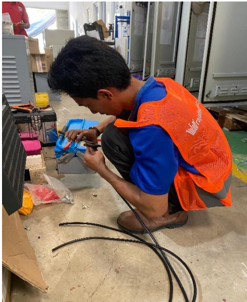
Gambar 2.11 Memotong Kabel Dengan Ukuran 70mm
