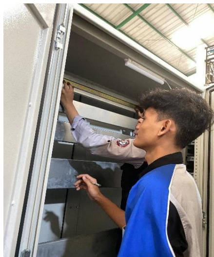
Gambar 2. 3 Pemasangan Din rail pada Panel
