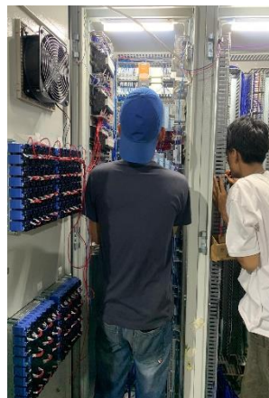
Gambar 2.4 (a).Proses pemasangan Kabel duct Pada panel Lay out (b).Komponen yang Sudah di Pasangkan Pada panel
