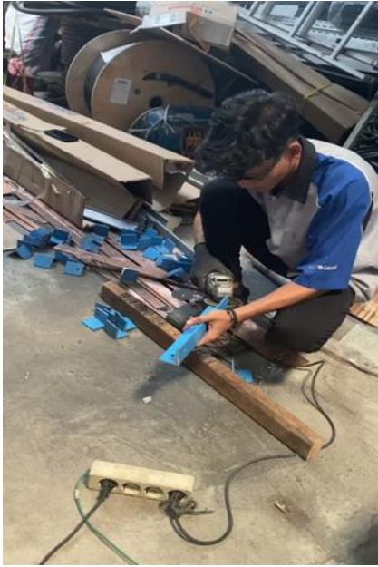
Gambar 2.10 Memotong kaki trafo
