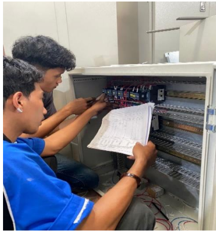
Gambar 2. 2 Melakukan wiring pada panel
