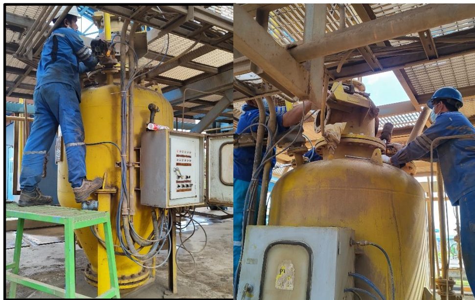
Gambar 2.8 Proses Pemasangan baru
