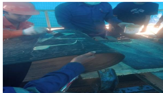
Gambar 2.17 Proses pengeleman pada permukaan yang akan dilem
