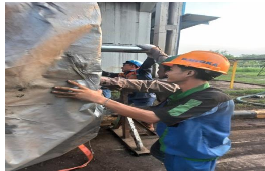
Gambar 2.7 Proses awal pemindahan belt baru ke area conveyor 2A
