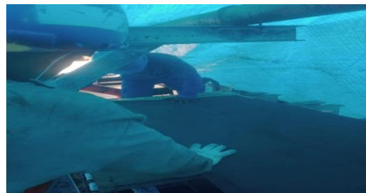
Gambar 2.19 Penyambungan permukaan belt yang sudah diolesi lem
