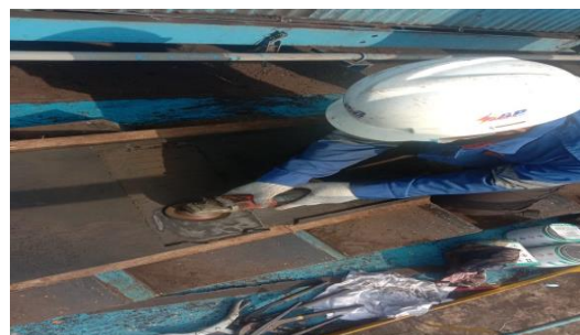
Gambar 2.13 Pembersihan sisa karet pada belt setelah dikupas menggunakan grenda
