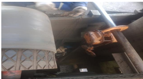
Gambar 2.8 Pemasangan chan block di conveyor 2A
