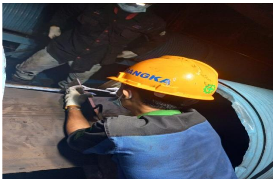
Gambar 2.10 Pemasangan besi siku pada belt
