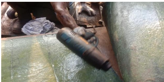
Gambar 2.18 Pengeringan lem menggunakan Gun Heater
