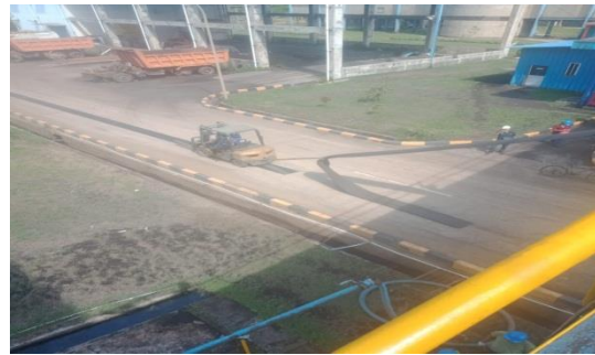
Gambar 2.15 Penarikan belt menggunakan forklift dan juga dibantu dengan running conveyor
