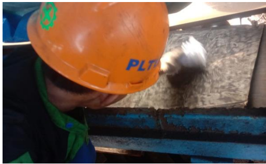
Gambar 2.14 Cleaning permukaan belt yang Akan dilem
