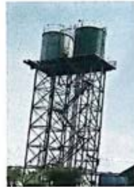
Gambar 2.24 Stasiun Water Treatment (WTP)
