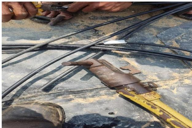
*Gambar 2. 6 Proses Penyambungan Skun Kabel*
